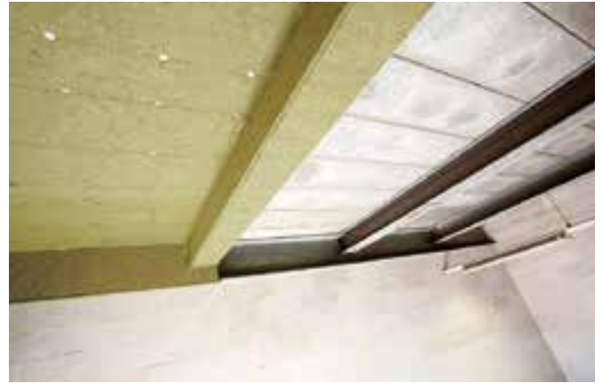
Erhöhung der Feuerwiderstandsdauer von Betondecken
