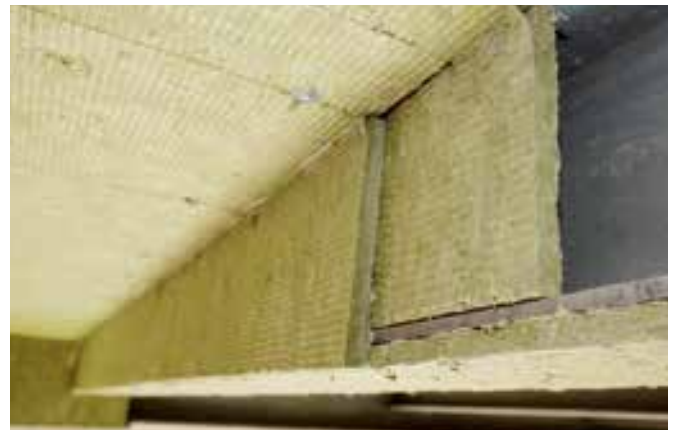
Stahlbau F30-A bis F180-A nach DIN 4102
